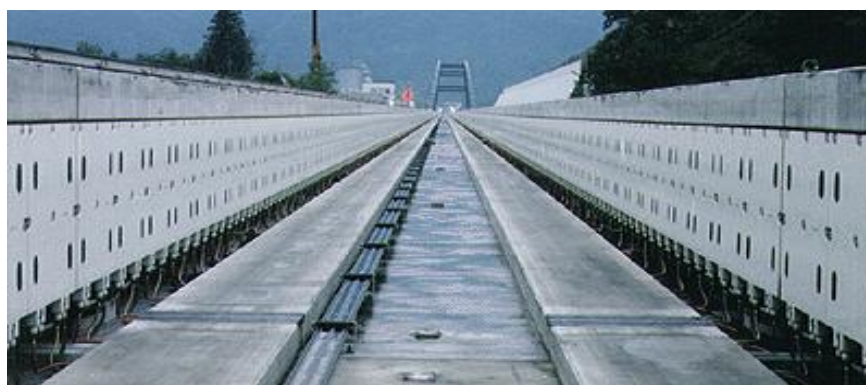
Рисунок 1.4 – Путевая структура для движения поезда по технологии электродинамического подвеса
