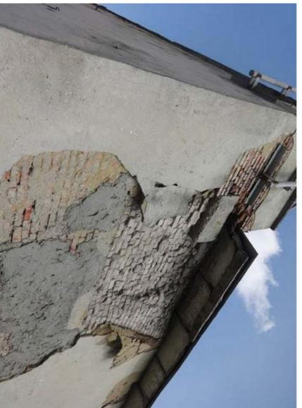
Разрушение наружных стен с вывалением кирпичной кладки
