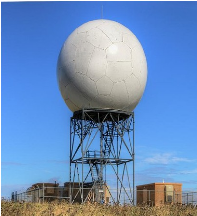
Рисунок 1.3 – Метеорологический радиолокатор TDWR
