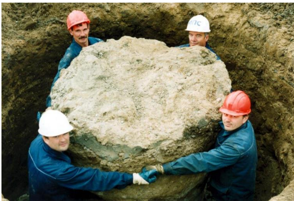
Рис. 2.13. Откопка шурфа для определения габаритов грунтоцементной сваи, выполненной по технологии Jet-2 [119].
