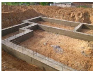
Рис.21 Ленточный фундамент
