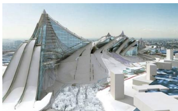
Рисунок 18 - Центр всепогодных видов спорта, Москва, арх. И. А. Василевский, М. Д. Хазанов и др., констр. Н. В. Канчели, 2007 г.
