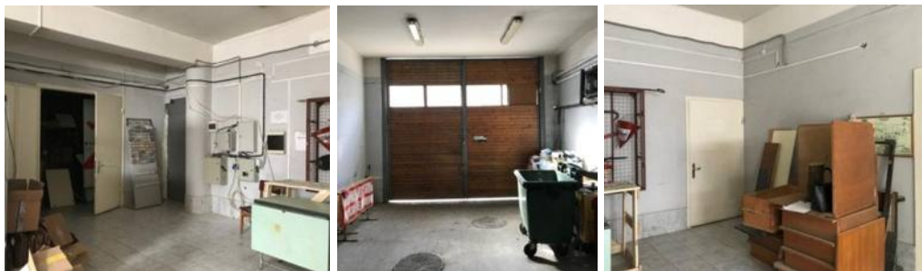
Рисунок 57 - Фотофиксация интерьера помещения до реконструкции
