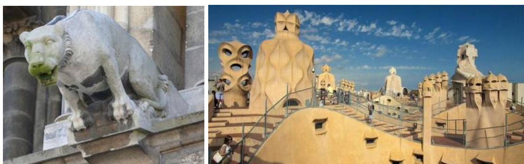
Рисунок 11 - Вытяжные шахты Каса Мила, Барселона, арх. Антонио Гауди, 1910 г.
