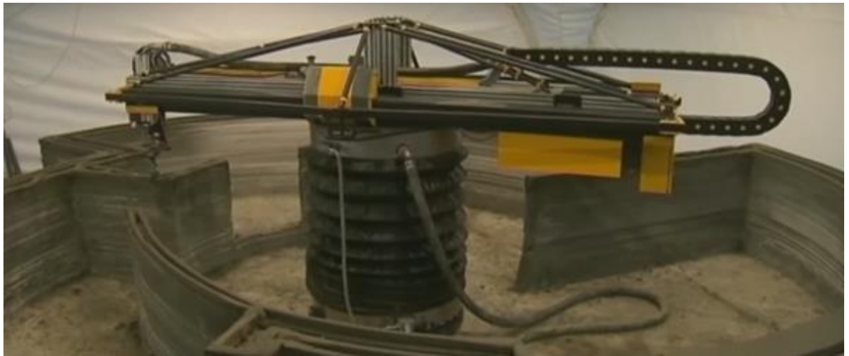
Рисунок 1 – Процесс строительства дома с помощью аддитивных технологий [20]
