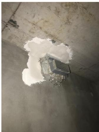
**Рис.2.2.2 «Загерметизированный вентканал»**
