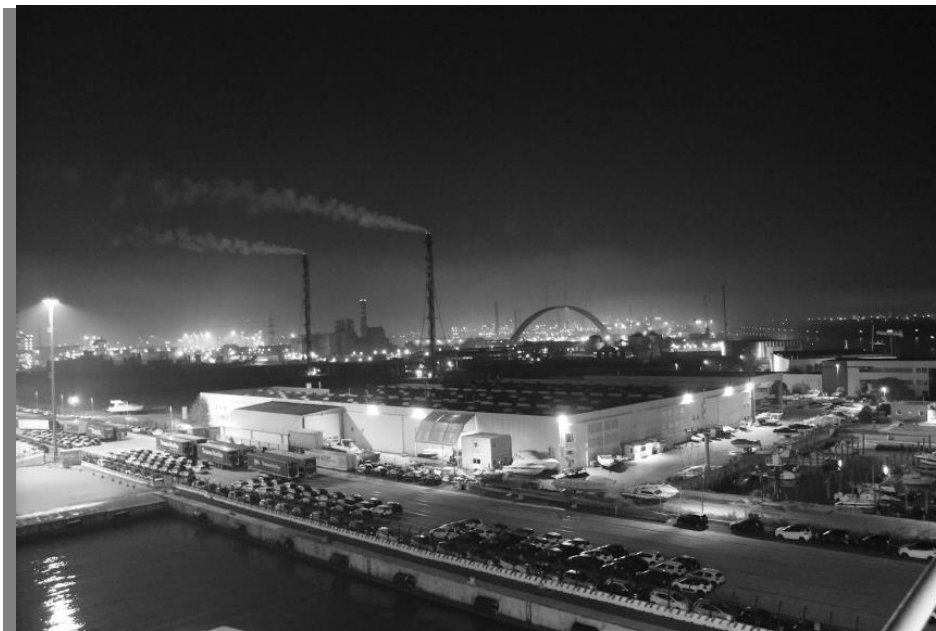
Рисунок 5 – Панорамный вид на электростанцию
