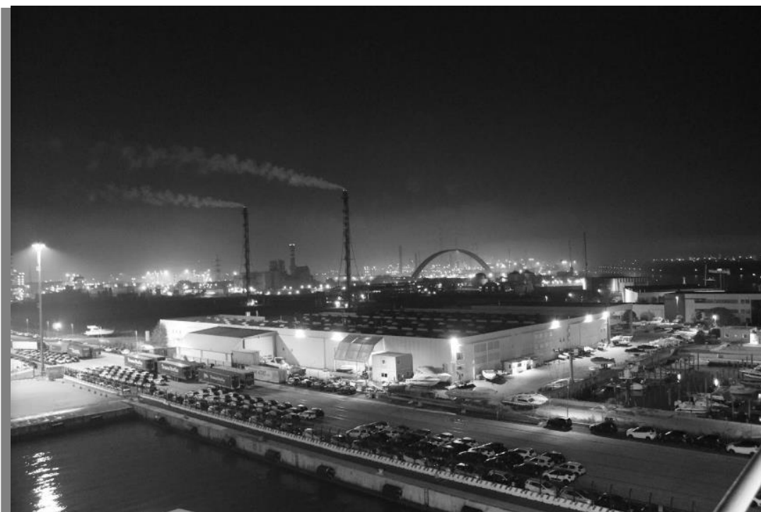
Рисунок 7 – Панорамный вид на электростанцию
