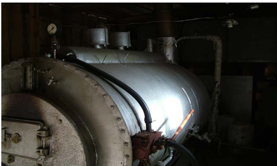
Рисунок 4.2. – Котел- парообразователь
