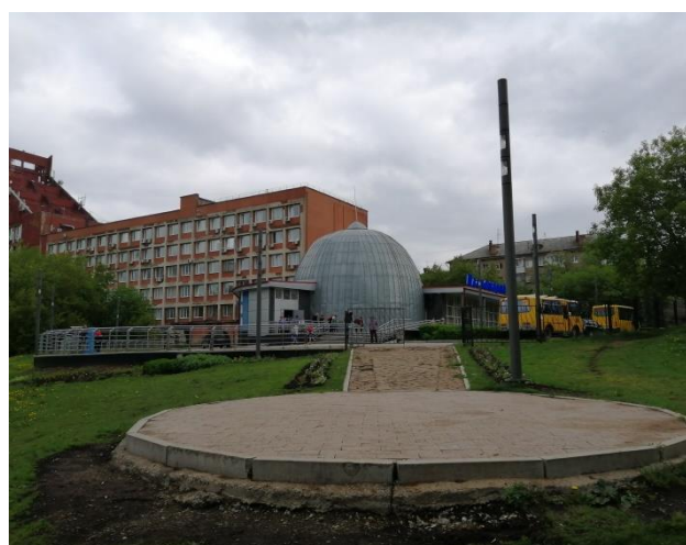
Рис. 6 Вид с площадки
