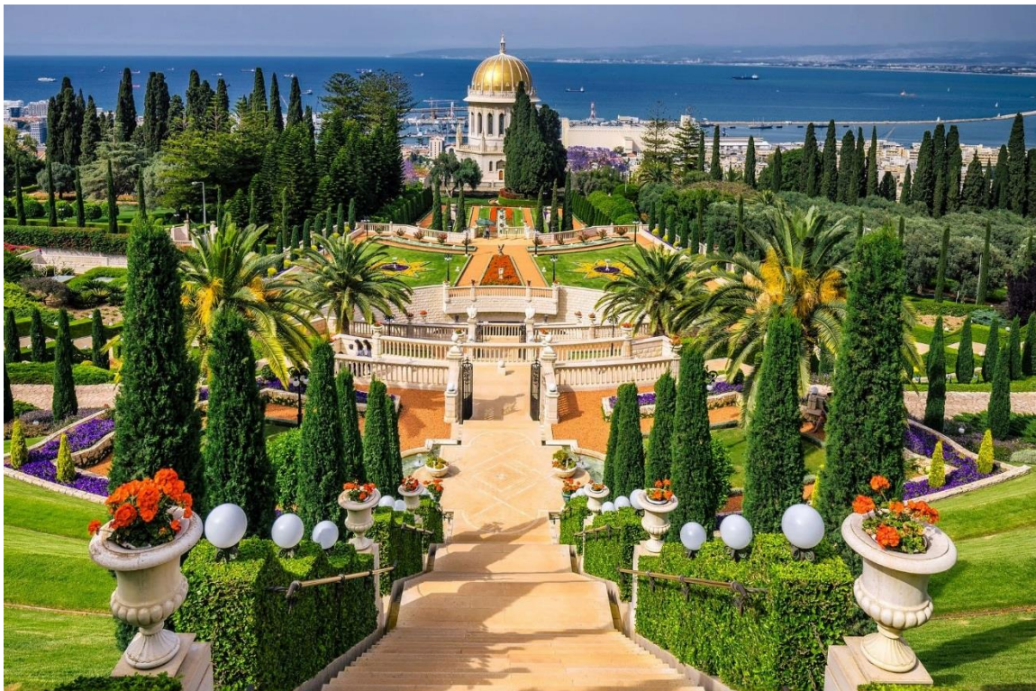
Рис. 6.4 Бахайские сады в Хайфе (Израиль): система водоотвода вдоль лестниц
