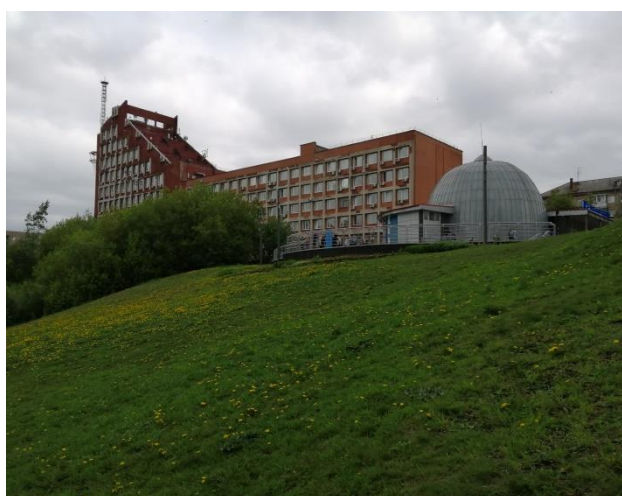
Рис. 5 Вид со стороны склона
