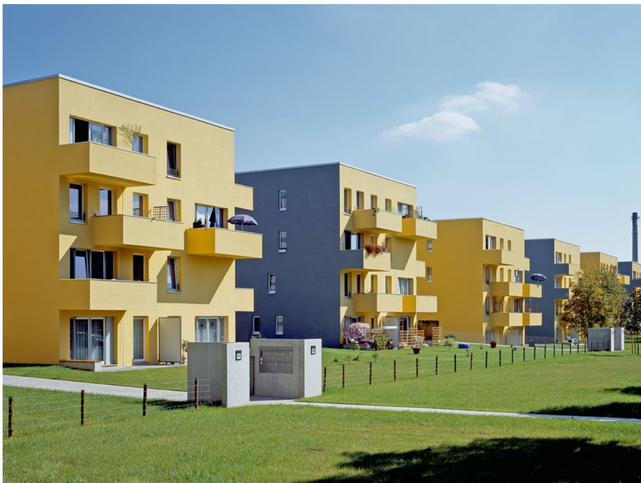
Рисунок 1.36. Пример реконструкции пятиэтажных домов типовых проектов
