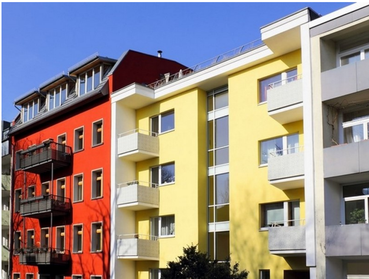
Рисунок 1.37. Пример реконструкции пятиэтажных домов типовых проектов
