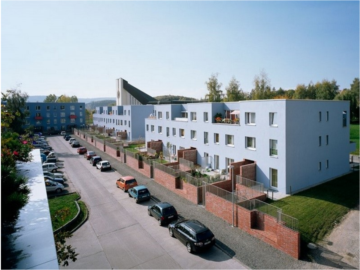
Рисунок 1.38. Пример реконструкции пятиэтажных домов типовых проектов
