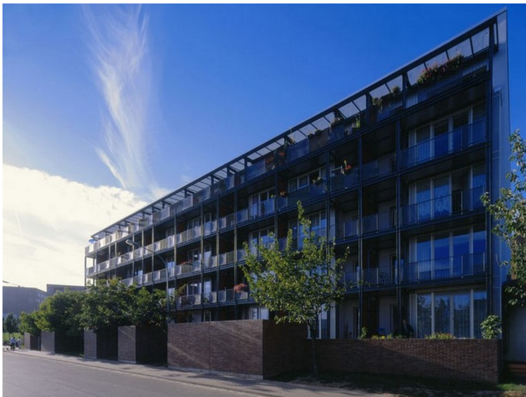
Рисунок 1.39. Пример реконструкции пятиэтажных домов типовых проектов
