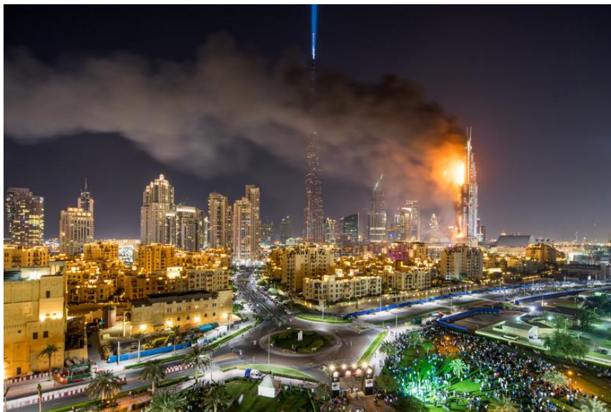
Рис. 1.2. Пожар небоскрёба в г. Дубаи
