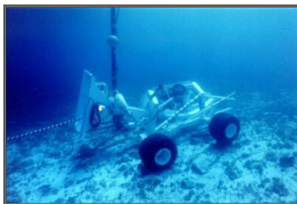
Укладка подводного силового кабеля с использованием телеуправляемого необитаемого подводного аппарата [11]
