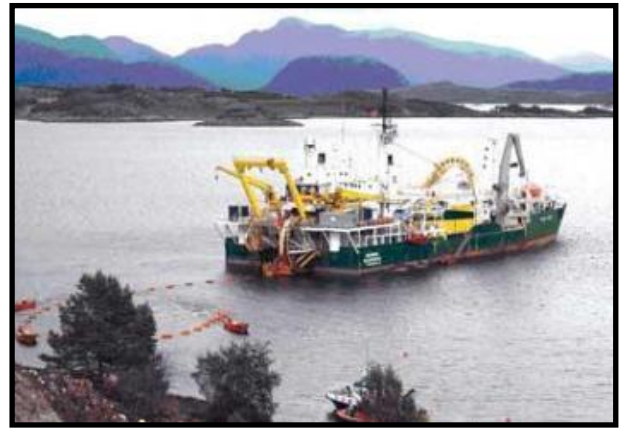
Прокладка подводного силового кабеля судном C/S Skagerak, Норвегия
