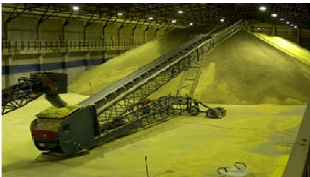
Рисунок 4. Складирование технической серы на НПЗ [9]
