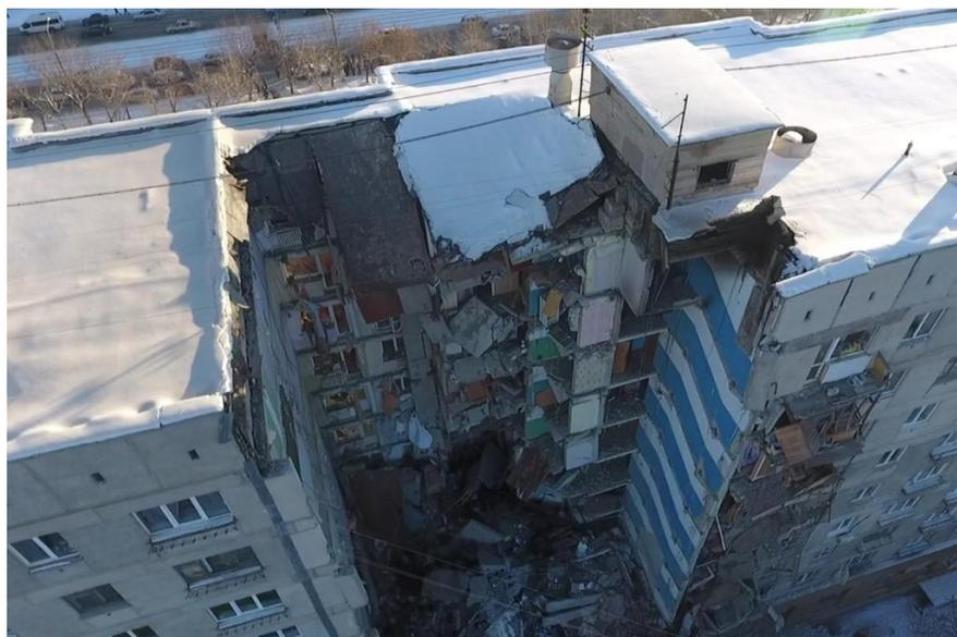
Рисунок 4.4 - обследование аварийного дома в Магнитогорске после взрыва газопровода
