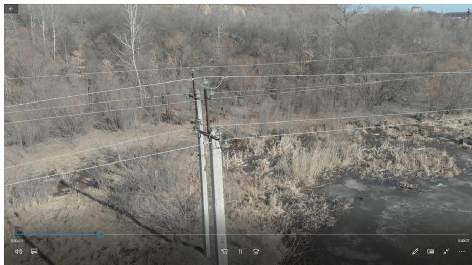
Рисунок 3.4 – Обход ЛЭП с применением квадрокоптера, осмотр проводов и изоляторов
