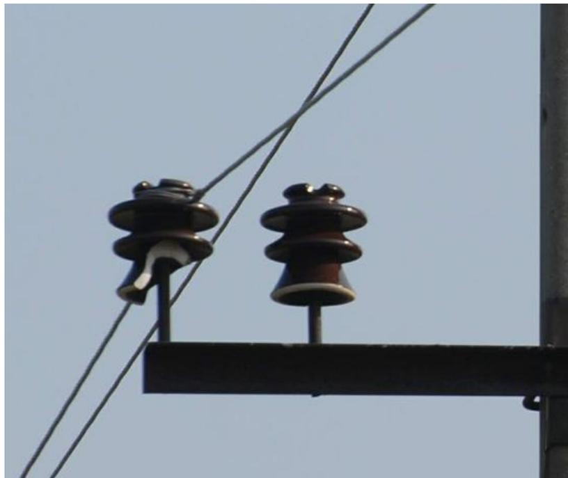
Рисунок 6.7 - Поврежденный фарфоровый изолятор
