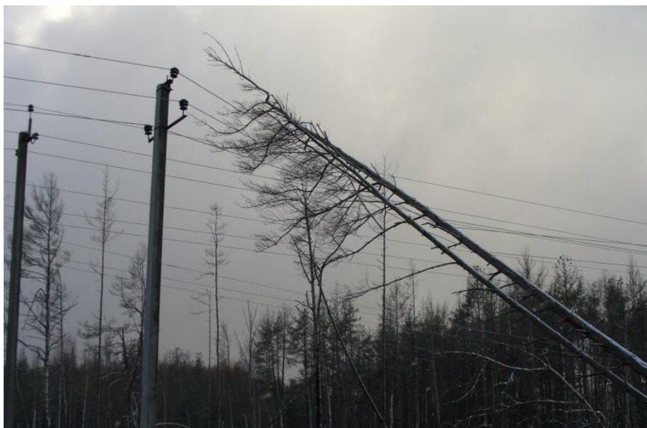
Рисунок 6.8 - Падение сухого дерева на ЛЭП
