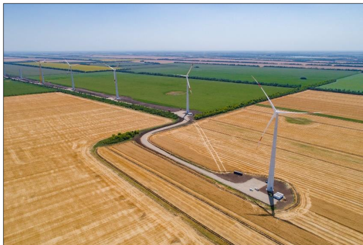
Рисунок 13 – Адыгейская ветровая электростанция [1]
