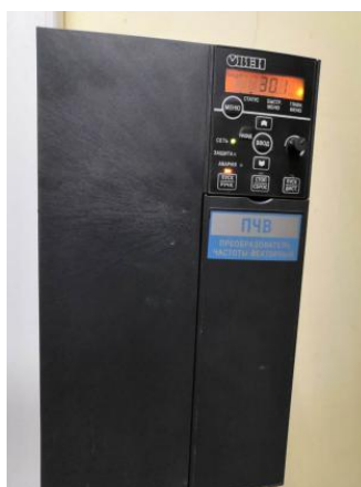
Рисунок 3.7- Частотный преобразователь циркуляционного насоса
