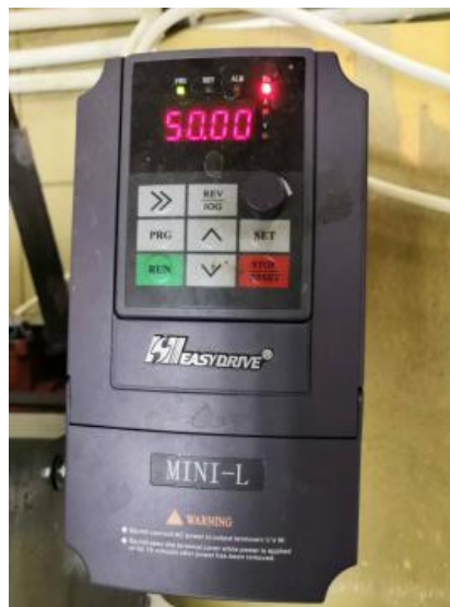
Рисунок 3.5 - Частотный преобразователь приводного двигателя
