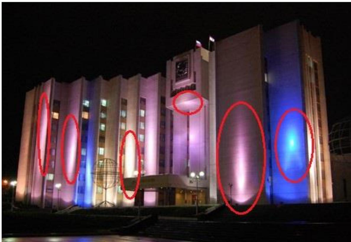
Рисунок 2.3 – Неравномерное освещение поверхностей на фасаде
