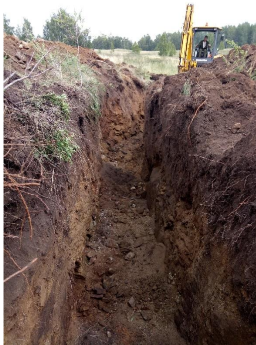
Рис. 3.3. Коры выветривания по базальтам в канаве (участок Танычау Буйдинской площади)
