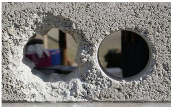
Рисунок 90 – Использование алмазов в строительстве при устройстве проемов [20]
