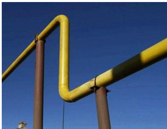
Рис. 4.1 – Фото надземной части газопровода-ввода к дому
