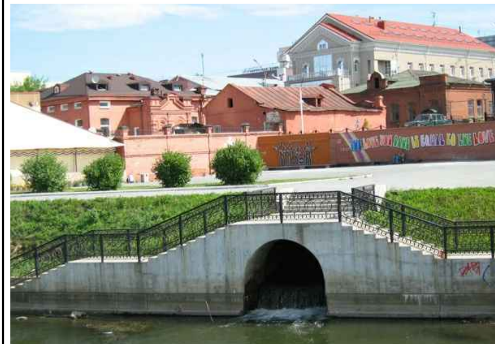
Река Мельковка, действующий водосброс
