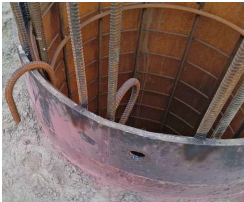
Рисунок 41 Монтажный крюк армокаркаса
