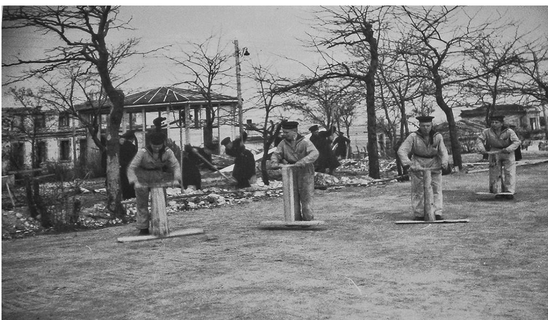
Рис 5.3. Работы по восстановлению Краснофлотского бульвара
