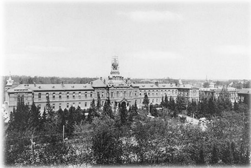
Больница имени бр. Бахрушиных на Стромынке
