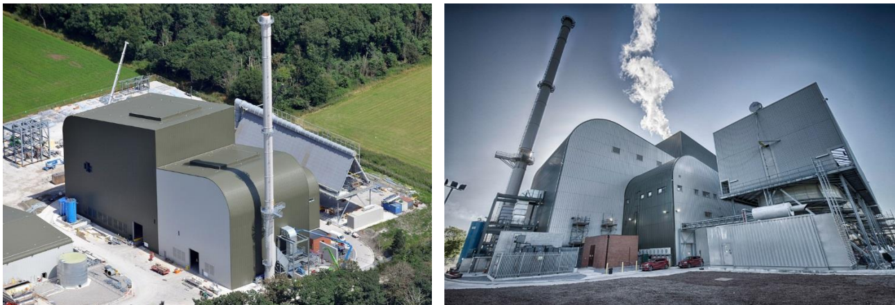
Рисунок 5 – Биоэлектростанция на древесных отходах мощностью 22 МВт в графстве Чешир, Англия
